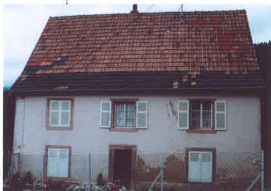
Tuiles mécaniques
