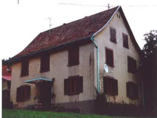
Toiture à coyaux
