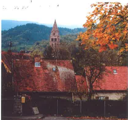
Tuiles en écailles et tuiles mécaniques
