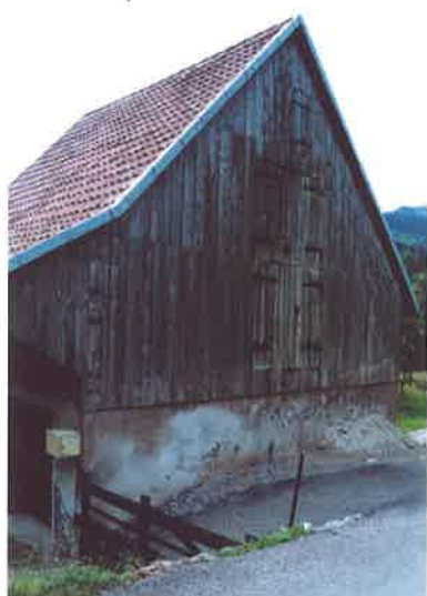
Pignon de la grange avec portes ménagées dans la partie haute du bardage qui correspondent au fenil haut et bas
